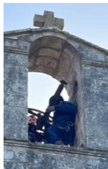
Figure 3 : Démontage du joug (Ph. MBG)
