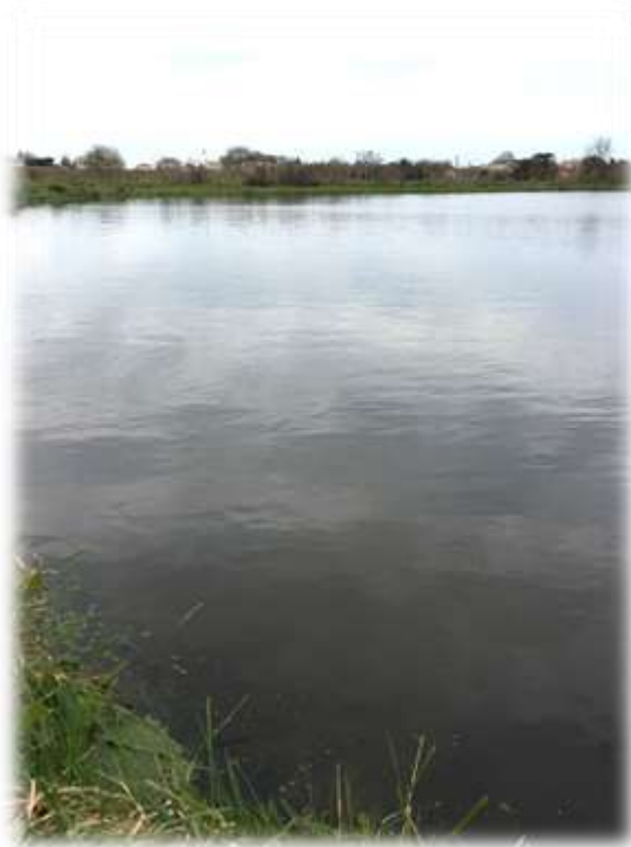
Figure 1 : Station de lagunage de Saint-Froult.
