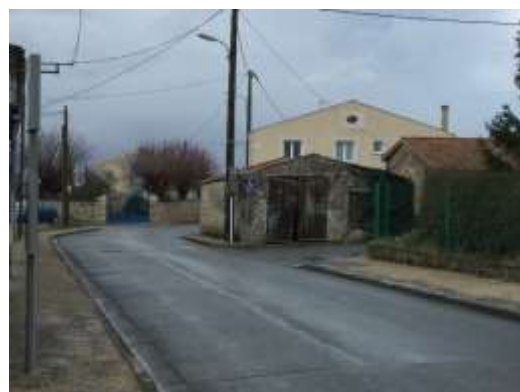
Figure 1 : Le carrefour de la Rue de l'Europe et de la Rue de l'Impervée avant travaux.
