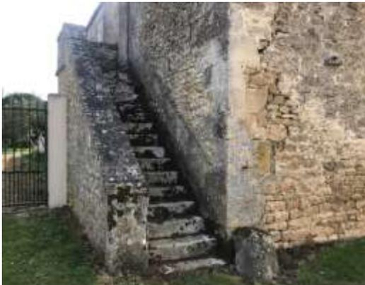
Figure 4 : Escalier d'extérieur en moellons, bouteille à l'angle, quelques pierres passantes...
