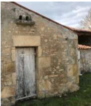
Figure 2 : Moellon-pigeonnier à deux ouvertures au-dessus d'imposants linteaux.
